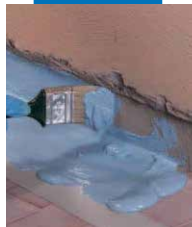
Полагане на Mapelastic® AquaDefense с четка между под и стена преди поставяне на лента Mapeband
