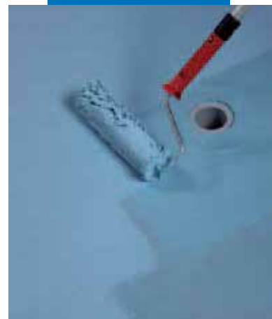
Нанасяне на втори слой Mapelastic® AquaDefense с валик
