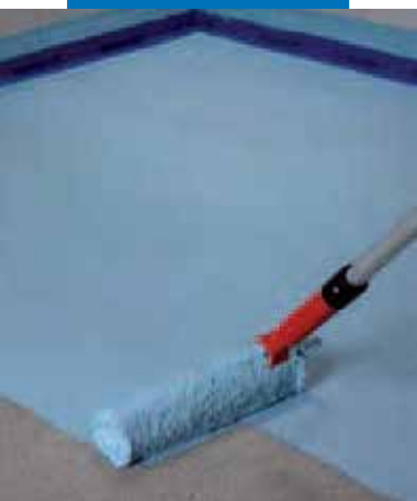
Нанасяне на първи слой Mapelastic® AquaDefense върху замазка
